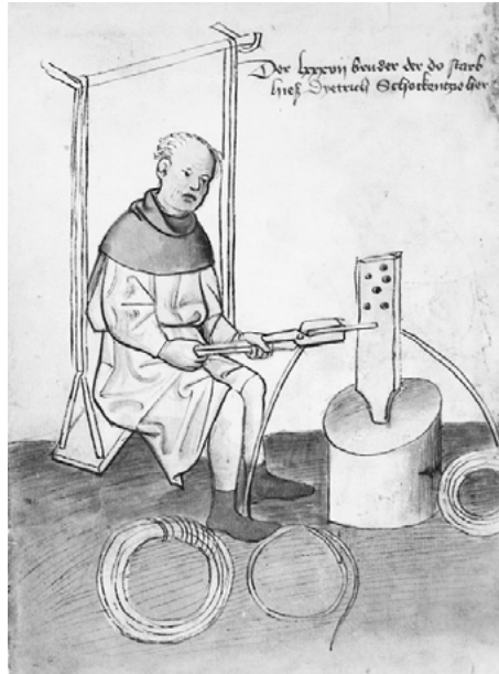
Fig. 1 Monje trabajando con la Hilera. Ilustración anónima alemana (1435-6).
